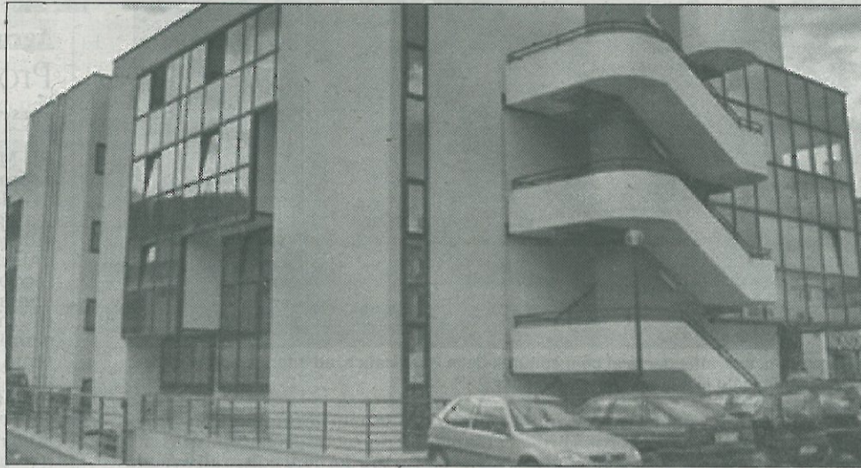
La sede del Poliambulatorio del Gallitello che sarà oggetto di lavori per 800.000 euro
