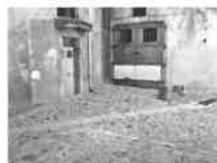
Foto della pavimentazione rifatta utilizzando ciottoli e basole esistenti.
